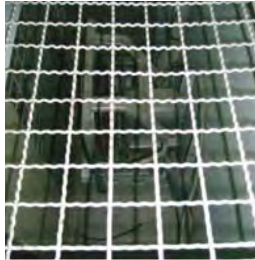
ตัวอย่างพื้นที่วางชุดระบายความร้อนแอร์แบบมาก แคมแปวเป็นสองชั้น ชั้นบนเป็นขอหัวหนึ่งชั้นล่างเป็นขออีกหัวหนึ่งเวลาซ่อมบำรุงก็ต้อเปิดประตู ปัญหาที่เจอคือเครื่องระบายความร้อนไม่ออก ตัวติดพัดลมระบายที่ตัวเครื่องเพิ่ม
