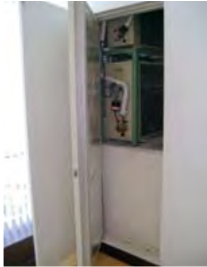
ตัวอย่างพื้นที่วางชุดระบายความร้อนแอร์แบบมาก แคมแปวเป็นสองชั้น ชั้นบนเป็นขอหัวหนึ่งชั้นล่างเป็นขออีกหัวหนึ่งเวลาซ่อมบำรุงก็ต้อเปิดประตู ปัญหาที่เจอคือเครื่องระบายความร้อนไม่ออก ตัวติดพัดลมระบายที่ตัวเครื่องเพิ่ม
